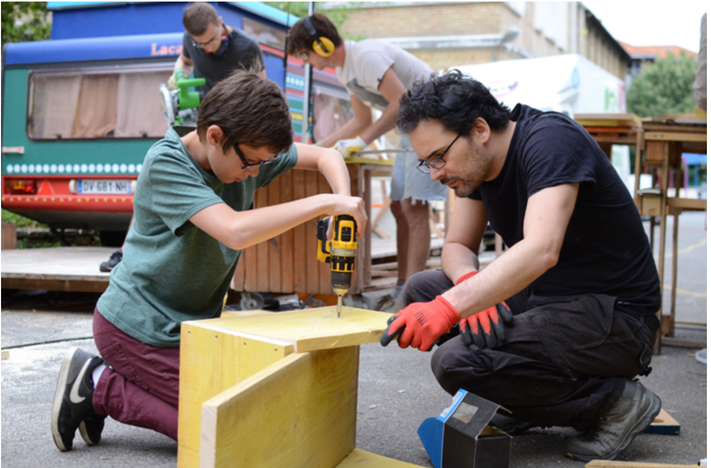
Construction de mobilier pendant les ateliers publics du Vendredi Chantier.
